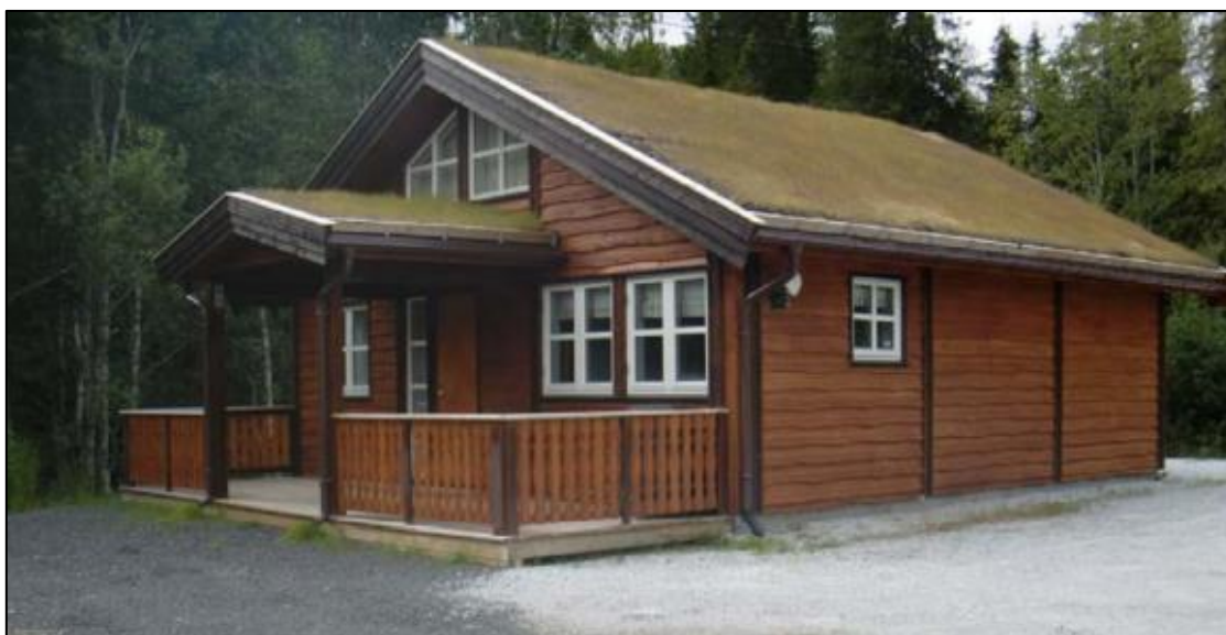
Figur 13 Elsfjord vannbehandlingsanlegg (Sandvik vannbehandlingsanlegg har tilsvarende uteseende)
